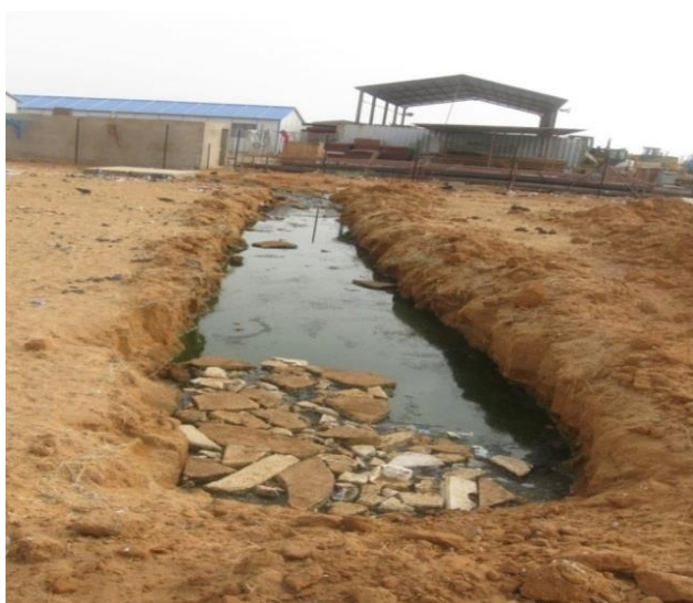
Photo 3: Tranchée côte Nord
