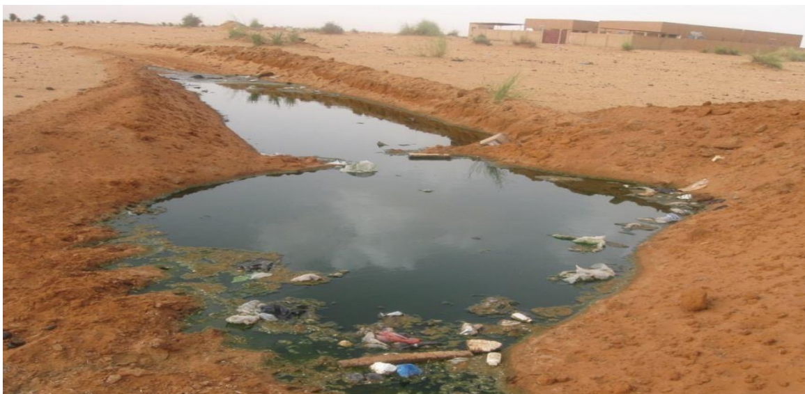
Photo 1: Nouvelle tranchée creusée pour recevoir les eaux usées
